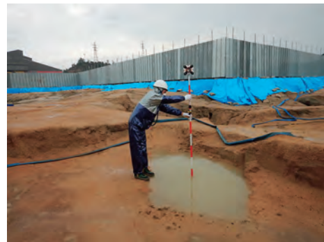
写真3-5-3-10 水面部の点群補測
