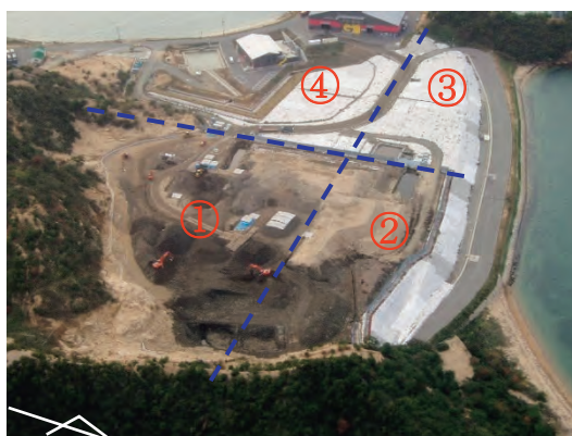
写真3-1-2-3-1 工区分け（平成17年11月撮影）
