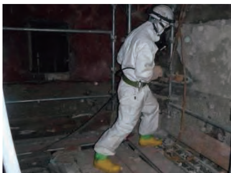
写真6-3-1-1 レベル3の保護具の着用
