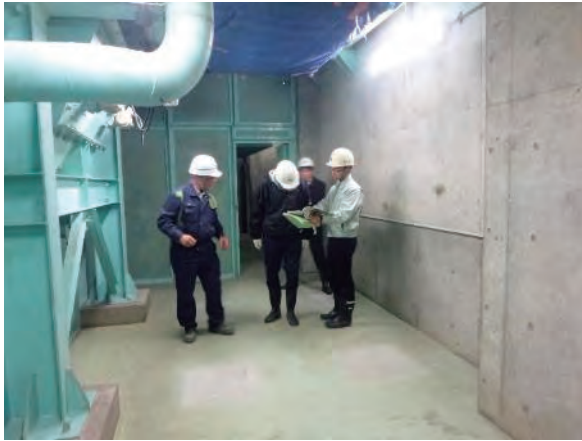
①北棟：粗大物搬送コンベヤ解体撤去後の状況確認
