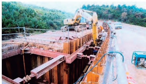
写真 2-2-3-1-1 北海岸での遮水壁の打設状況
