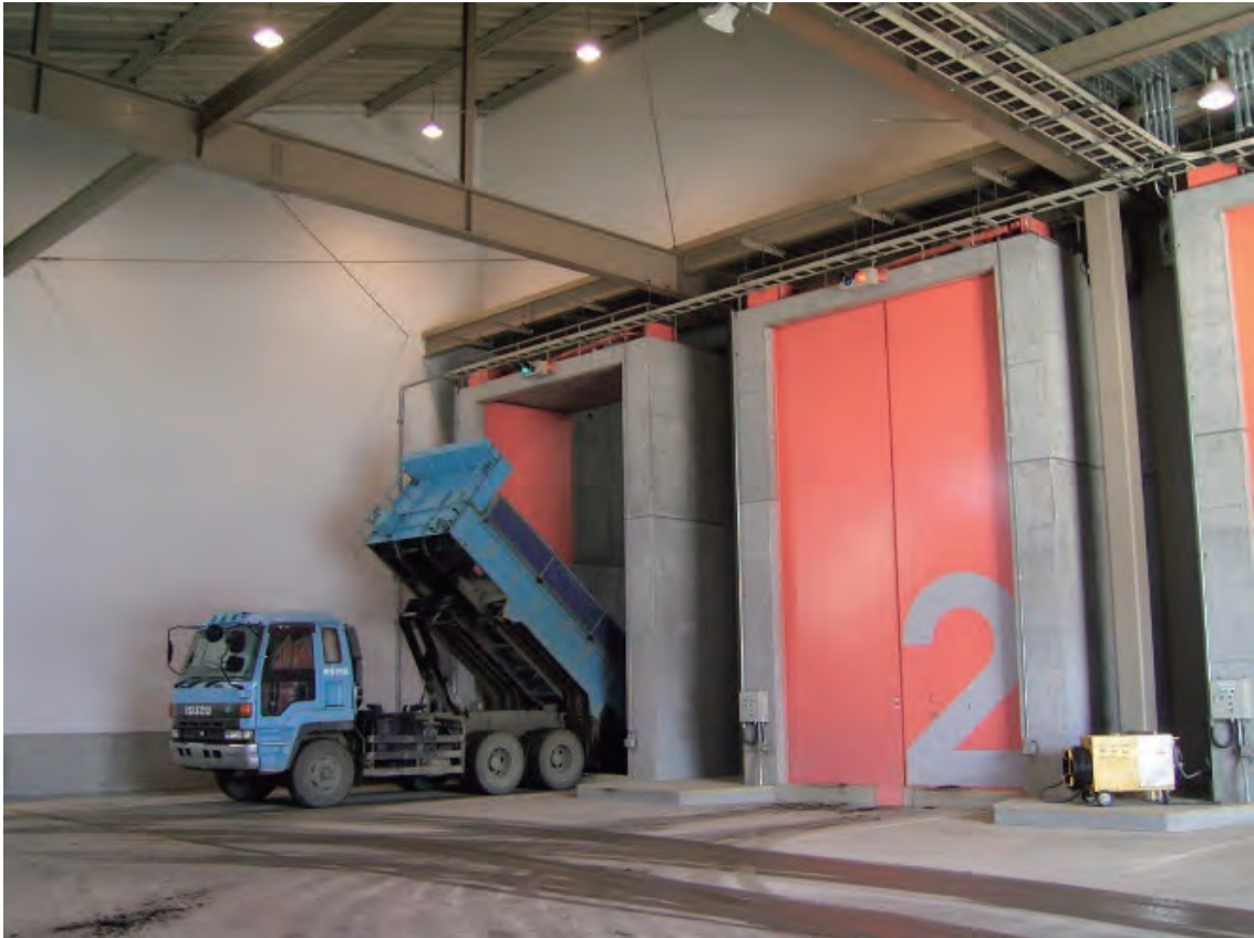
写真 10-5-20 中間保管・梱包施設 保管ピット
