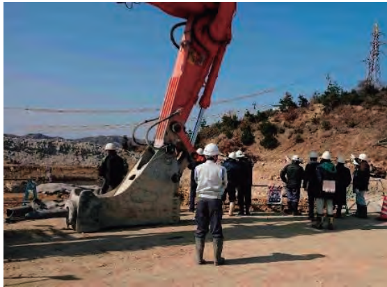
写真6-2-1-1 ピットの解体状況の確認
