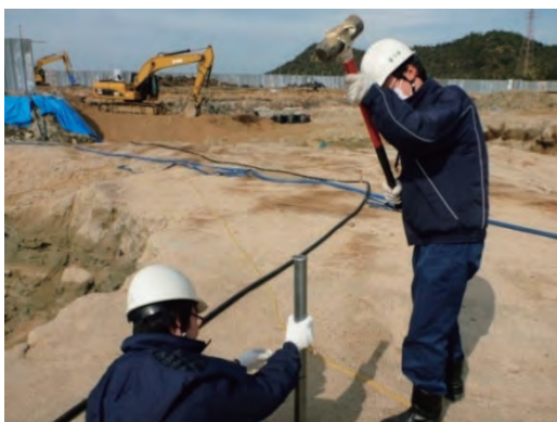
写真3-1-2-2-4 土壌のサンプリング作業の状況
