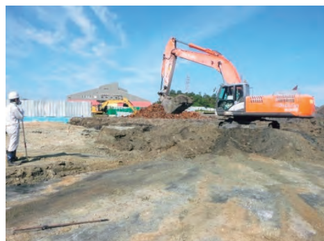
写真3-1-2-2-1 底面掘削の実施状況
