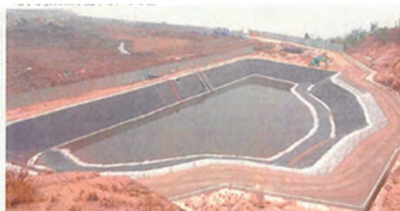
写真5-2-3-2 貯留トレンチ
