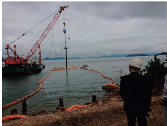
写真6-2-3-2 鋼管杭撤去作業の確認
