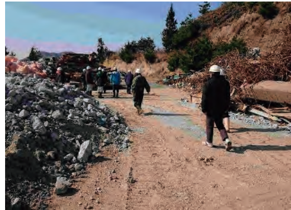
写真6-2-1-2 施設撤去廃棄物等の保管状況の確認
