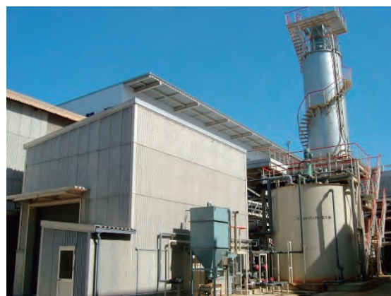
写真7-1-2-1 溶融飛灰再資源化施設
