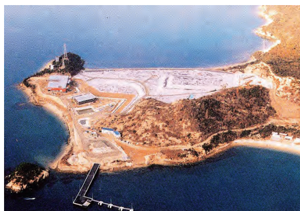
写真2-2-3-1 暫定的な環境保全措置工事完了後の 豊島処分地の全景
