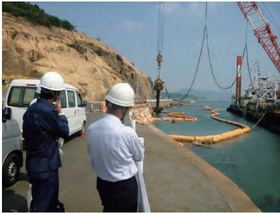
写真6-3-2-1 杭撤去作業の確認（南より撮影）
