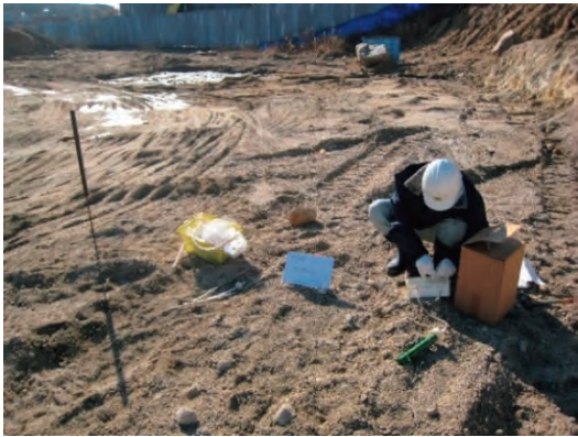
写真3-1-2-2-2 土壌ガス調査の状況
