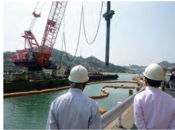
写真6-3-2-2 杭撤去作業の確認（北より撮影）
