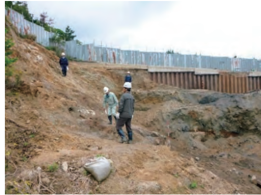
写真3-1-2-2-3 岩盤部の掘削完了判定の状況
