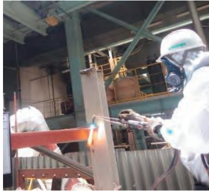
③レベル3 保護具の着用状況（溶断時）
