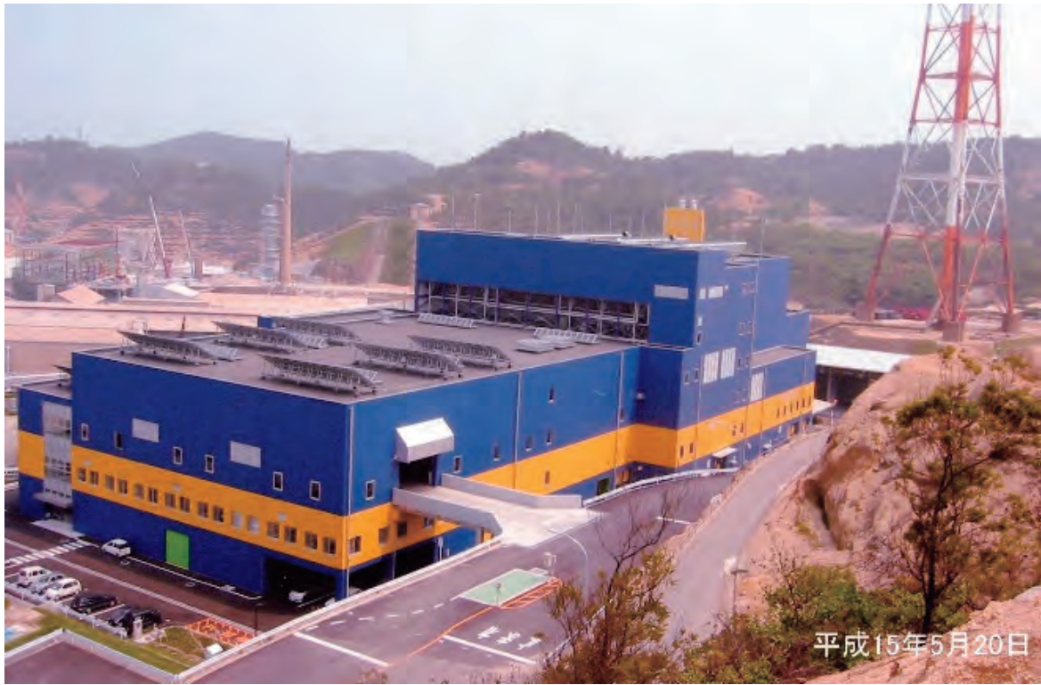
写真 10-5-32 中間処理施設 全景 1
