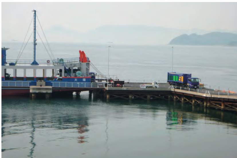
写真 3-1-4-2-1 廃棄物運搬船「太陽」の荷卸し状況（豊島専用栈橋）
