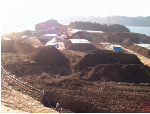
写真3-1-3-2-1 混合面設置状況（平成17年3月）
