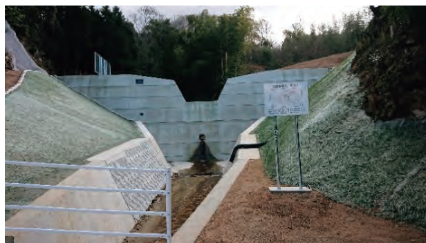
写真3-2-2-2 溶融スラグコンクリート使用事例
