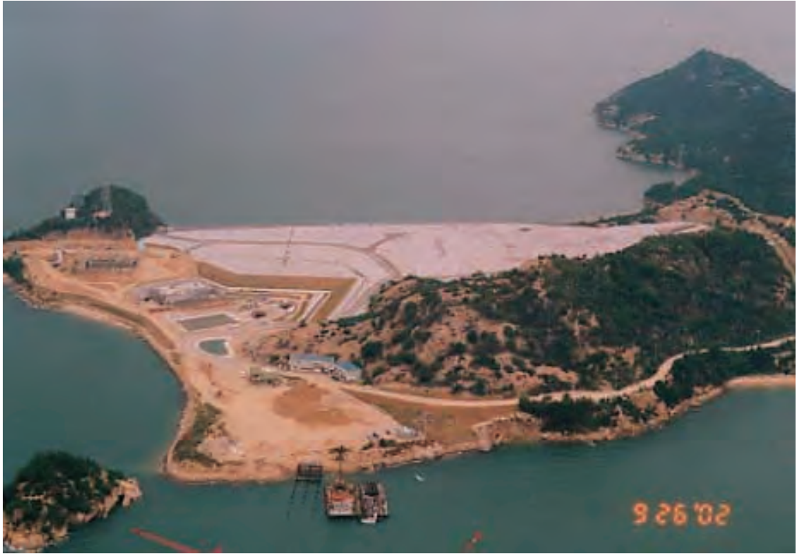
写真 10-5-5 豊島航空写真 平成 14 年 9 月（暫定的な環境保全措置工事完了後）
