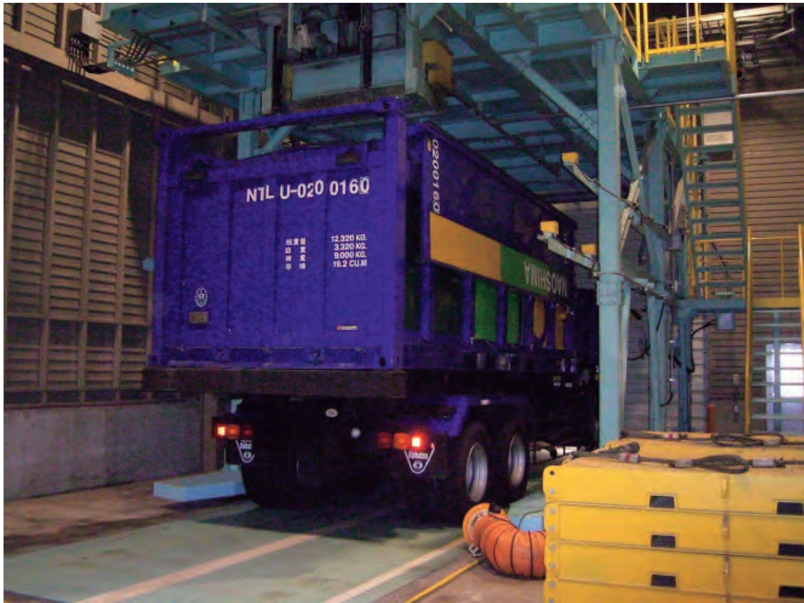
写真 10-5-21 中間保管・梱包施設 積込室
