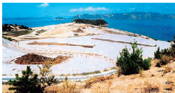
写真2-2-3-3-1 透気・遮水シートの敷設状況
