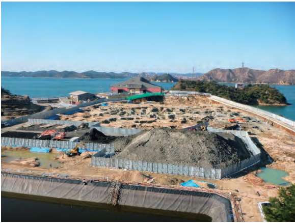
写真3-1-3-2-3 最終混合面設置状況（平成28年12月）
