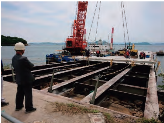
写真6-2-3-1 床版撤去作業の確認
