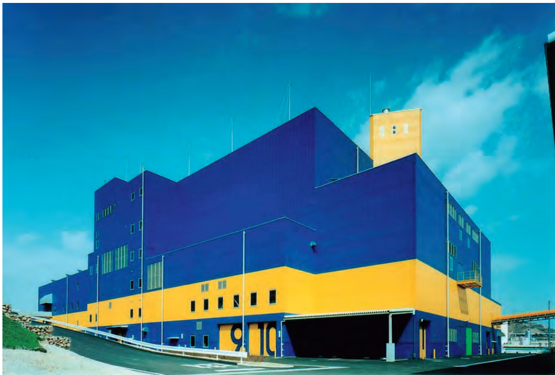
写真 10-5-33 中間処理施設 全景 2
