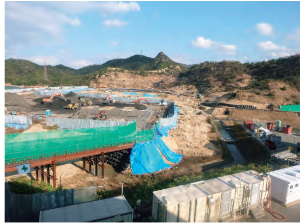
写真3-1-3-2-2 混合面設置状況（平成27年12月）
